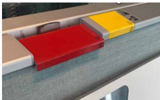
b. Nödknapparna på Cibes Air, stoppknappen är röd och larmknappen är gul. Nödstoppsknappen aktiveras genom att man trycker den nedåt. För att avaktivera den, tryck ner den exponerade metallspetsen och dra upp nödknappen.
