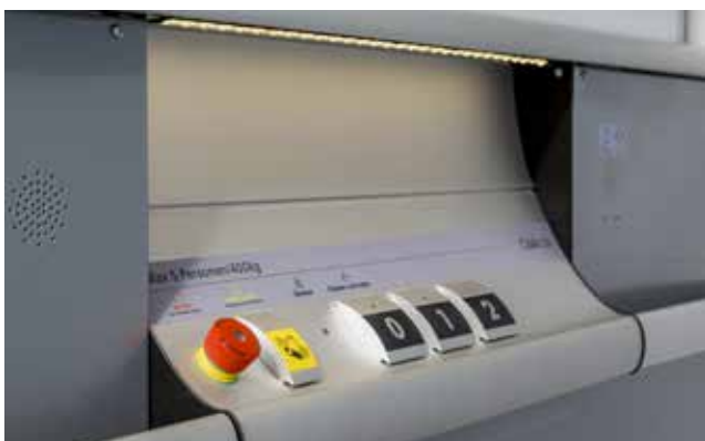
a. Nödknapparna på Cibes A5000, stoppknappen är röd och larmknappen är gul.
