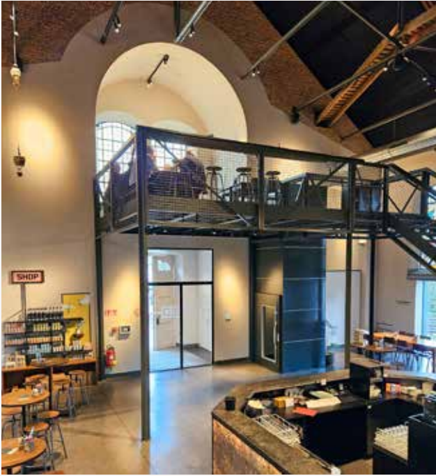
Mikrobryggeriets restaurangbar har installerat en Cibes A5000 plattformshiss för att göra loftplanet tillgängligt.
