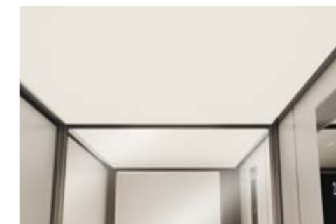
Plafond met LED-diffuusverlichting (250 LUX)
