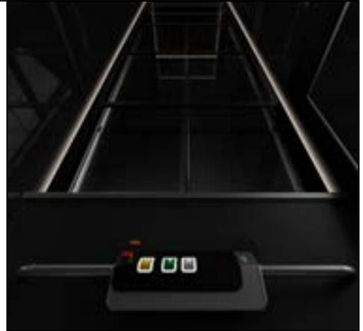
Éclairage de gaine
