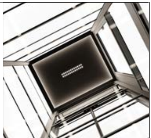
Plafond rétroéclairé avec diodes lumineuses LED
