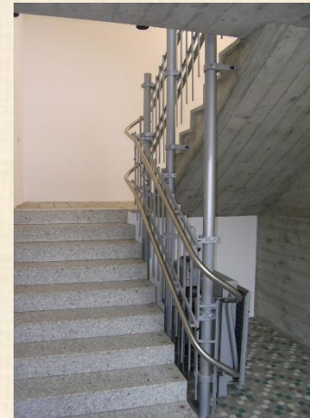
Stützen im Treppenaug: Hier ist es möglich, einen Teil der Fahrbahn ins Treppenaug zu verlagern. Ein Anbohren der Stufen ist nicht nötig.
