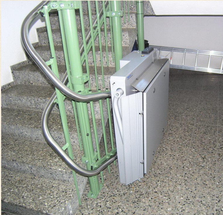
Haltestelle Untergeschoss, Plattform geschlossen
