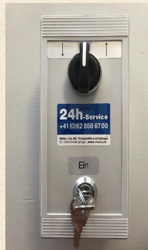
Fixe Rufstelle mit Funkmodul mit oder ohne Schlüsselschalter
