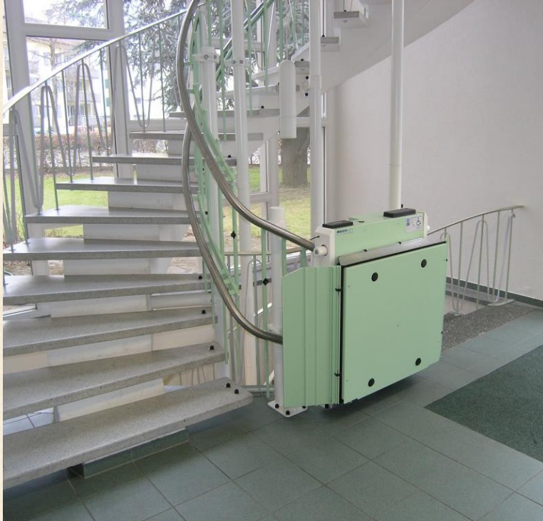
Haltestelle Eingangsgeschoss, Plattform geschlossen
