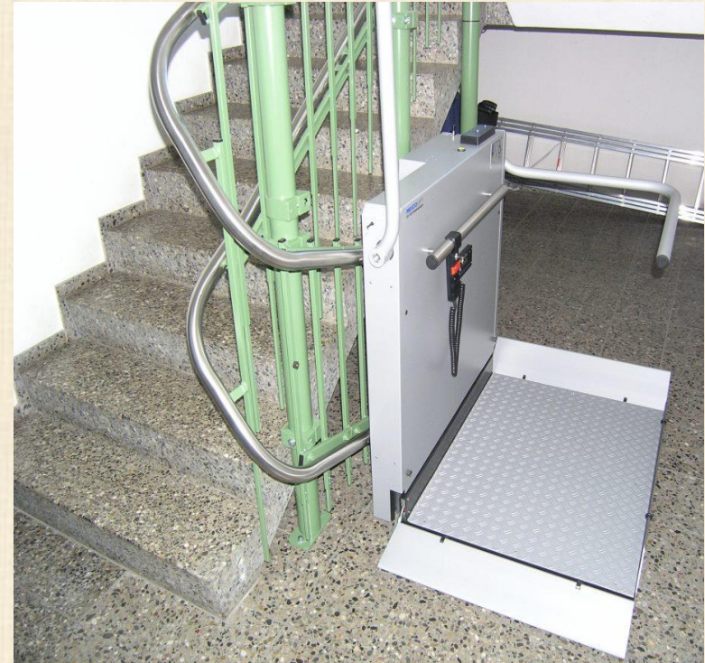
Haltestelle Untergeschoss, Plattform offen zum Gebrauch
