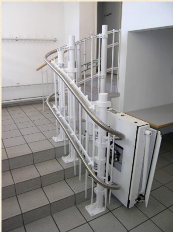
Stützen-Befestigung: Die Stützen werden auf den Stufen aufgestellt und mit diesen verbohrt.
