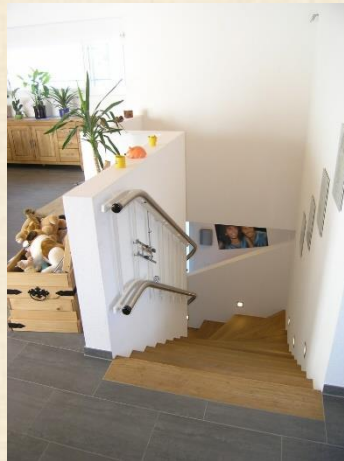
Wand-Befestigung: Die Fahrbahn wird mit Winkeln direkt an die Wand geschraubt. Minimaler Platzverbrauch auf der Treppe.
