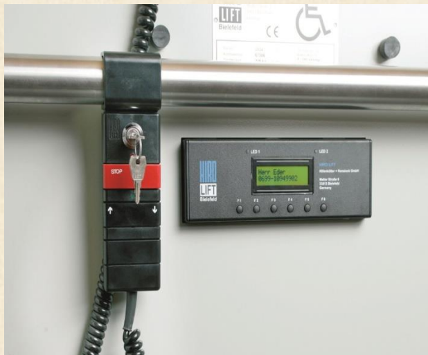
Bedienbox auf der Plattform an einem Spiralkabel mit oder ohne Schlüsselschalter
