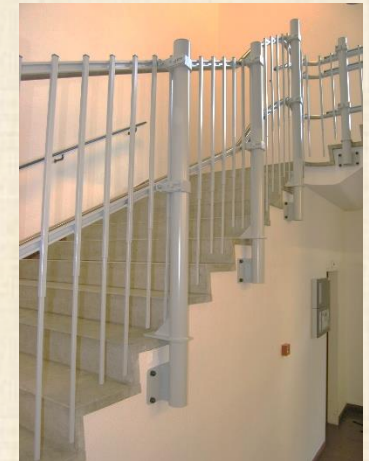
Wangen-Befestigung: Die Stützen werden im Treppenaug an der Wange befestigt. Ein Anbohren der Stufen ist nicht nötig.
