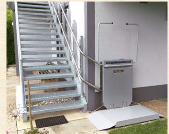
Stützen auf Treppenwange
