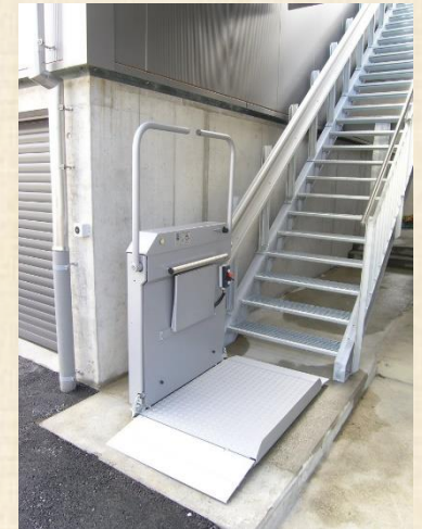
Stützen auf Treppenwange
