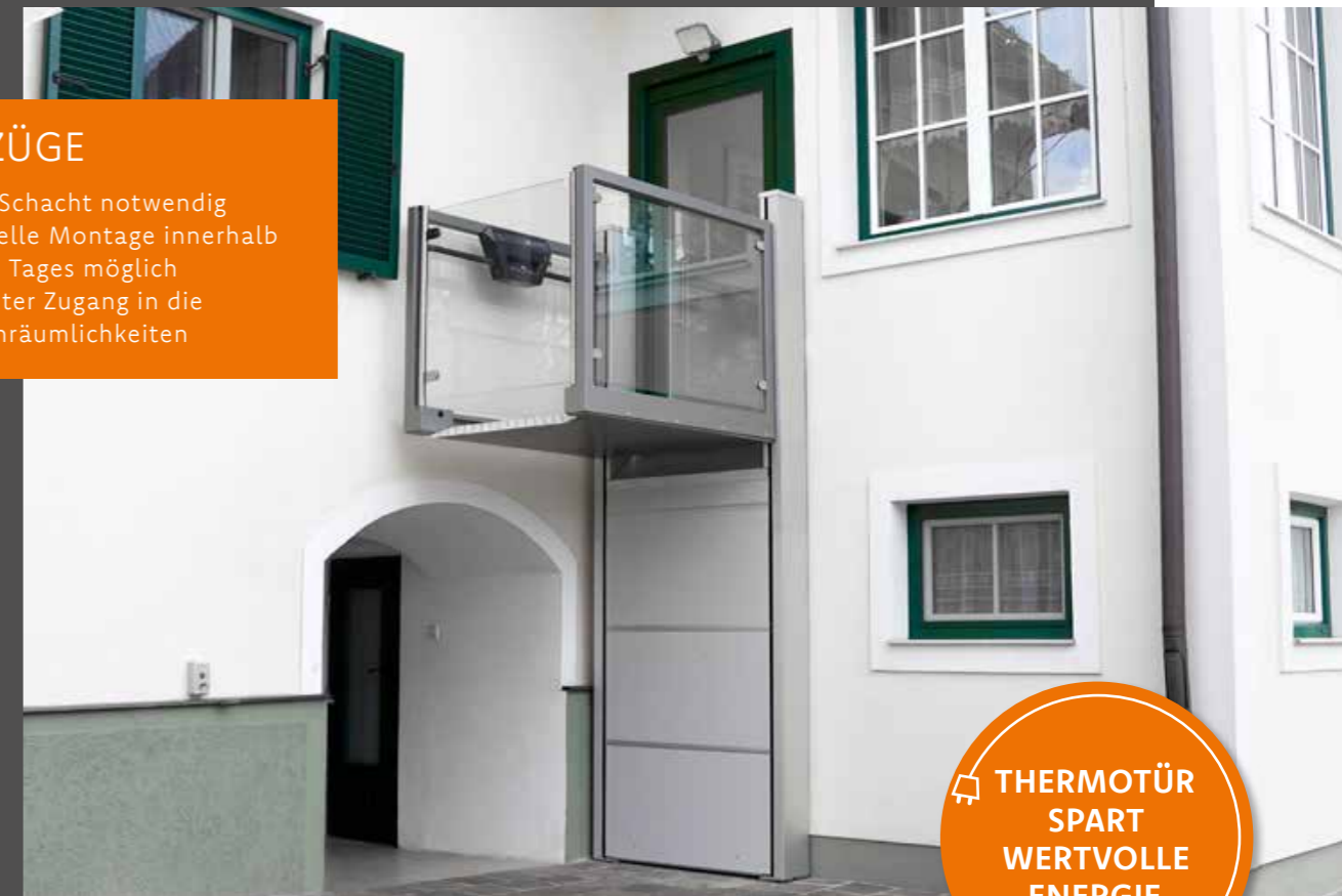
Nachträglicher einfacher Einbau eines Hublifts mit Thermotür.
