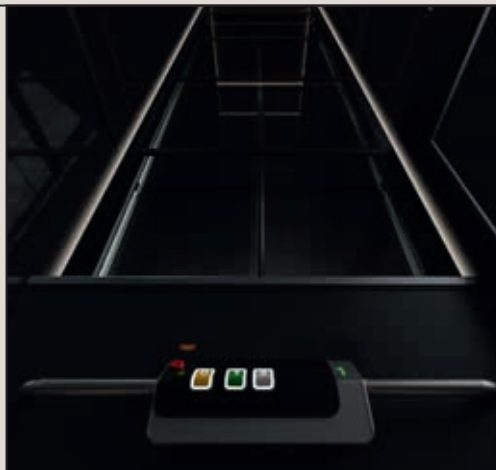
Beleuchtung des Schachts
