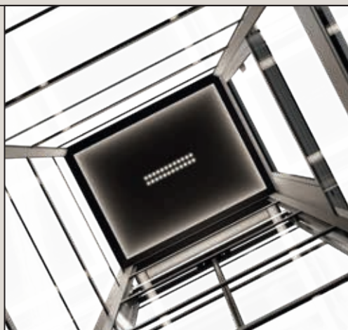
Indirekt beleuchtete Decke mit zusätzlicher direkter LED-Beleuchtung
