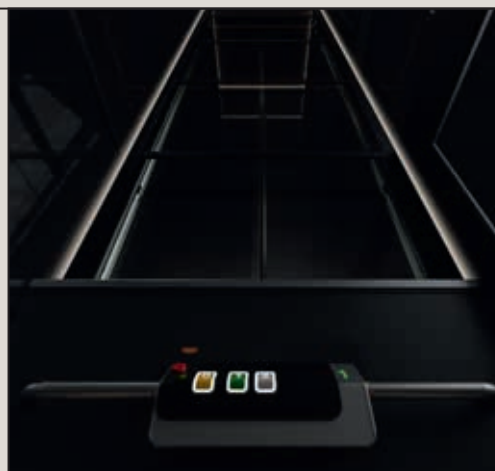
Iluminación del hueco
