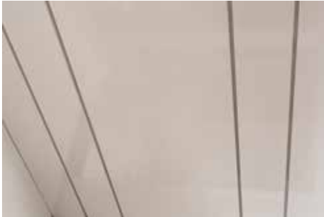
Techo liso (sin iluminación)
