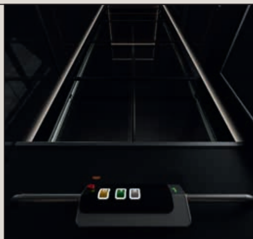
Éclairage de gaine
