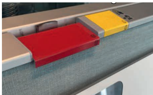
b. Boutons d'urgence du Cibes Air : le bouton d'arrêt est rouge et le bouton d'alarme est jaune. Le bouton d'arrêt d'urgence est activé par une pression vers le bas. Pour le désactiver, appuyer vers le bas sur l'embout métallique exposé et tirer le bouton d'urgence vers le haut.
