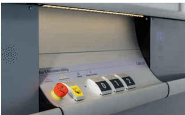
a. Boutons d'urgence du Cibes A5000 : le bouton d'arrêt est rouge et le bouton d'alarme est jaune.
