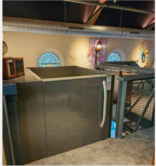
L'élévateur est doté d'un portillon de 1,1 mètre de haut au dernier étage, ce qui donne à l'espace limité de la mezzanine une impression d'ouverture et d'espace.
