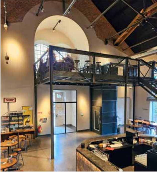
Le resto-bar de la micro-brasserie est équipé d'une plateforme élévatrice Cibes A5000 pour faciliter l'accès à la mezzanine.
